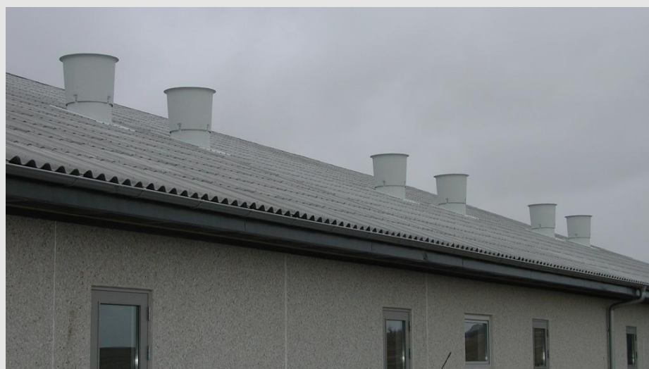
Til regulering af afkastet er der monteret et regulerbart spjæld, som kan betjenes automatisk eller manuelt efter ønske.
