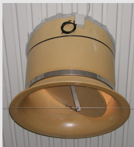
Til regulering af afkastet er der monteret et regulerbart spjæld, som kan betjenes automatisk eller manuelt efter ønske.
